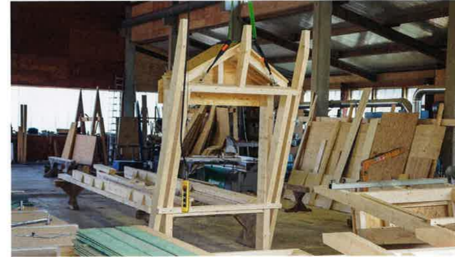
Auch bei Dachstühlen strebt Holzbau Rößner einen hohen Vorfertigungsgrad an, wie diese vorgefertigte Gaube zeigt.
